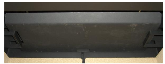
バッフル取付け時
